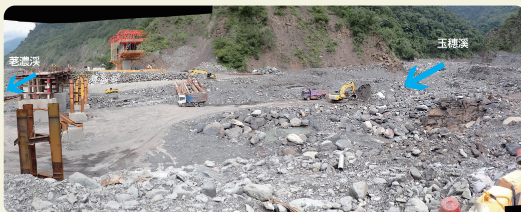
写真-2 玉穗溪の大規模土砂流出の状況
