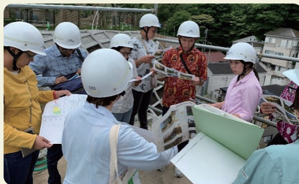
横浜での斜面保全工事見学(6月17日)
