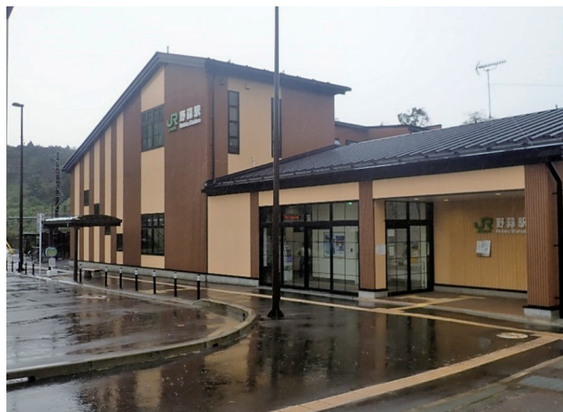
写真-4 津波の被害を受けて移転した現在の野蒜駅
