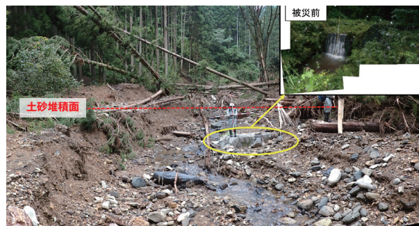
図-12 治山堰堤における土砂の堆積痕跡(8月30日撮影)
