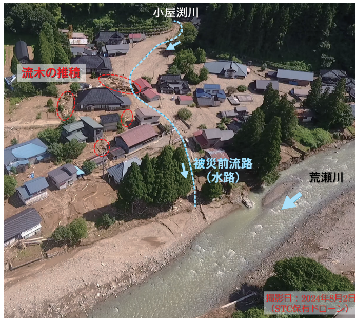
図-5 小屋淵集落の被害状況
