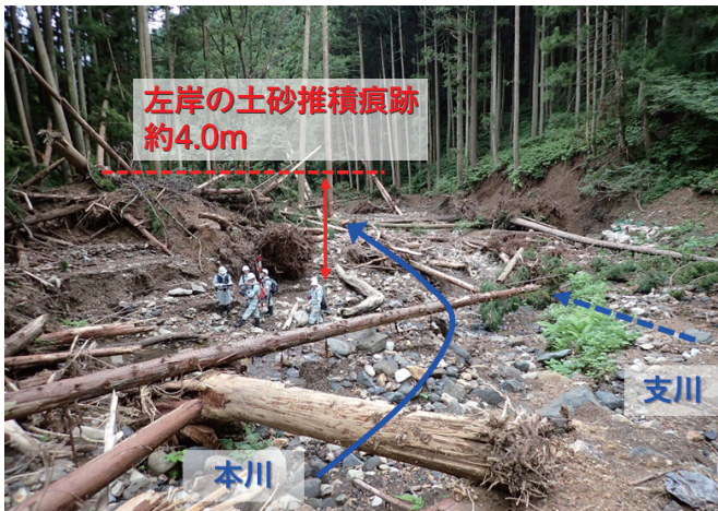
図-10 上流側右支溪の合流点の状況(8月30日撮影)
