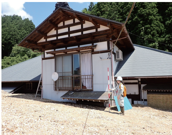
図-13 1階部分が土砂に埋もれた家屋(8月2日撮影)
