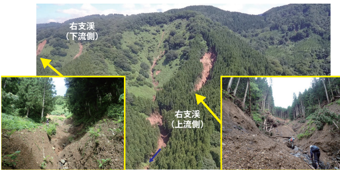
図-9 右支溪における崩壊地の状況(8月30日撮影)
