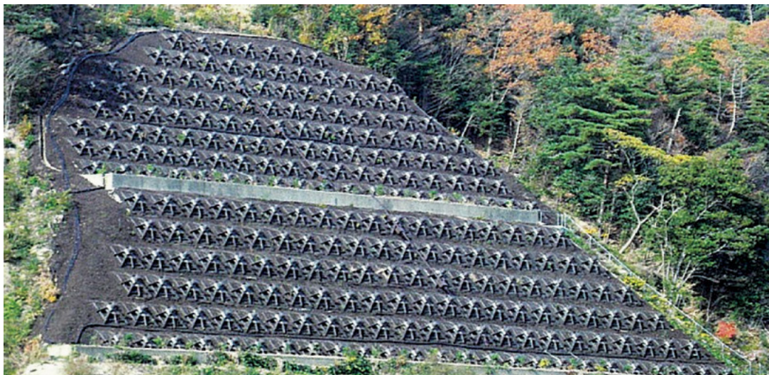
法面工事での施工事例
