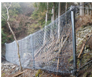
施工事例 奈良県 (RXE-3000、3000kJ対応型)
