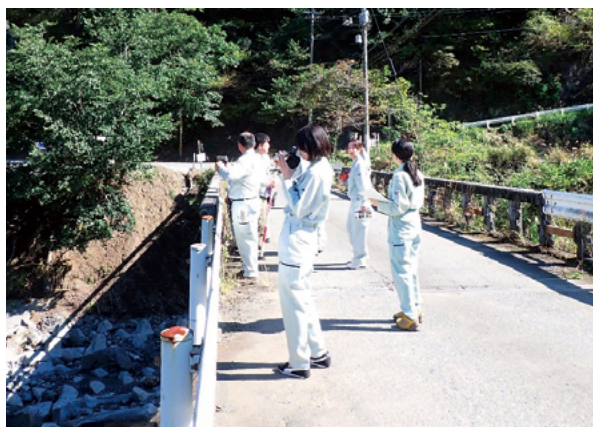
春木川橋にて保全対象の確認および橋梁の桁下クリアランスの計測
