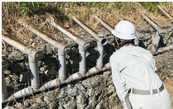
地すべり地内の排水状況を確認している様子。現地調査では、事前の準備をした上で、周りの方に質問しながら、自分の目で現場を見る力を養っていけたらと思います。(群馬県藤岡市譲原にて)
