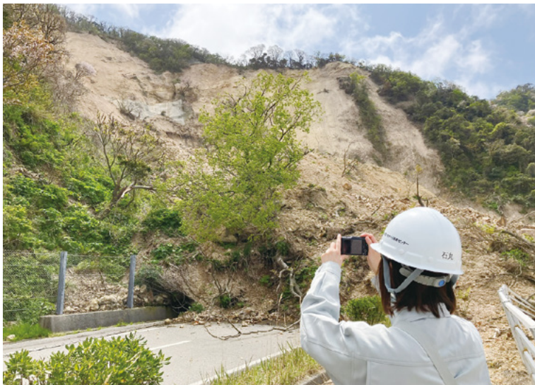
能登半島の調査の様子。この原稿を執筆している現在、能登半島地震の発生から3か月が経ちました。この度、被害に遭われた方に心よりお見舞い申し上げますとともに、1日も早い復旧をお祈り申し上げます。(石川県珠洲市仁江町にて)
