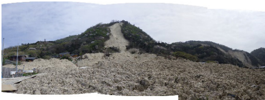
写真-5 珠洲市仁江町
