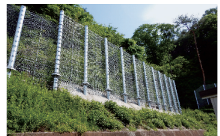
施工事例 (上:群馬県 H=3.5m、下:長野県 H=5.6m)
