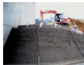
施工中(長繊維混入補強土吹付工)
