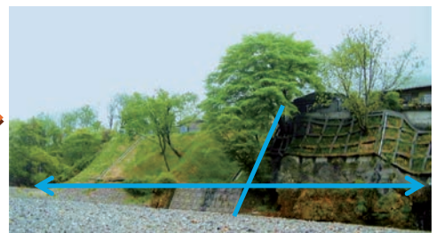
ロービングウォールⅡ工法 (法面保護タイプ)
