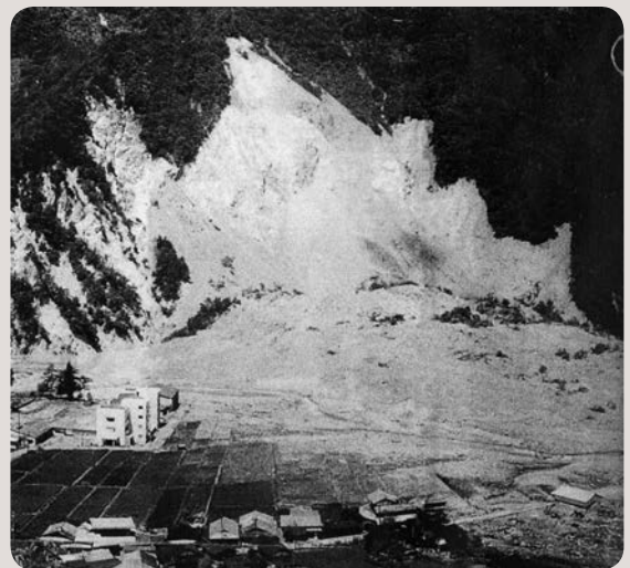
写真-3 大西山大崩壊(1961・6・29三六災害)(国交省天上河川事務所(2012))
