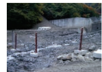
根固めブロックに差し込む（富士川水系春木川）
