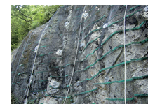
ポリエチレンネット（落石防止ネット）大嘉産業HPより
