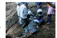
土のう積みのワイヤーネット包み（静岡県小山町）
