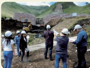
写真-4 熊本県阿蘇市の鋼製砂防堰堤建設現場
