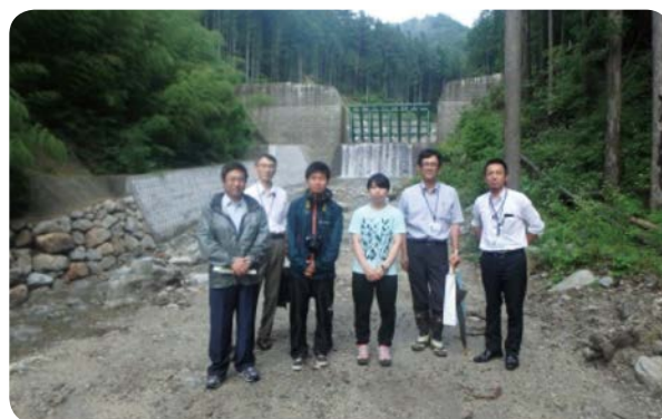
写真-3 梨子沢第2砂防堰堤
