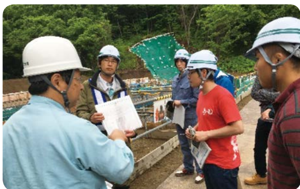
写真-1 砂防堰堤の施工現場の見学
