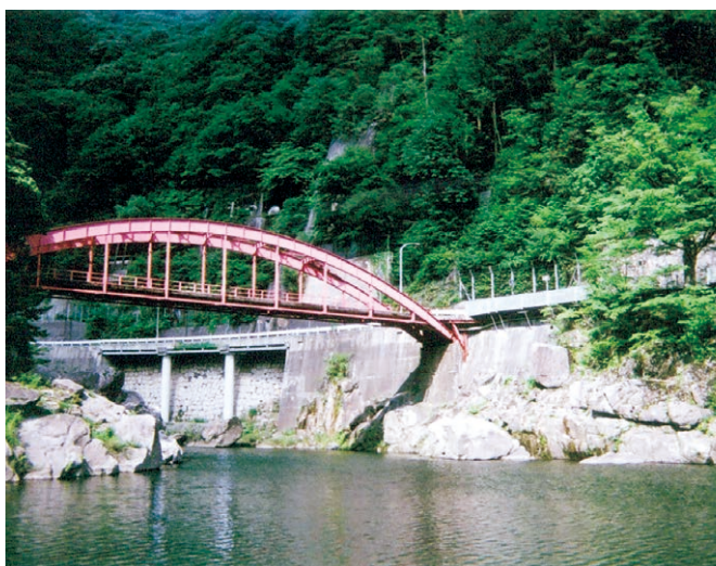
写真-4 棧の傍らにできた鉄筋の橋(1963年)
