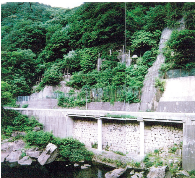
写真-3 棧部分の今日(かつてこの急崖の岩の間に丸太と板を組み、 藤蔓等で結わえた姿でありました)
