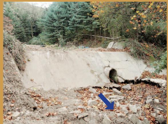
写真-5 土石流を捕捉した床固工
