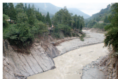
写真-4 土砂の堆積が進行している中流部
