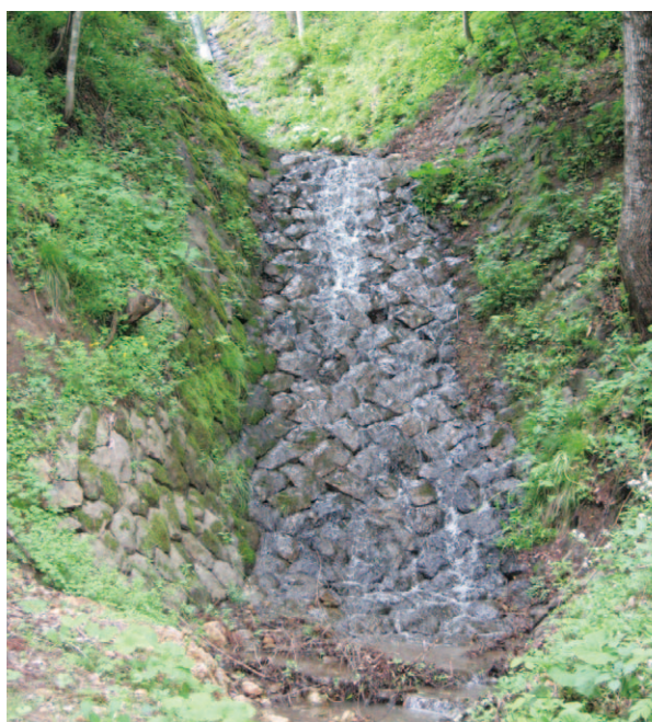
写真-5 堅固な護岸のある水路工（滝ノ下沢）
