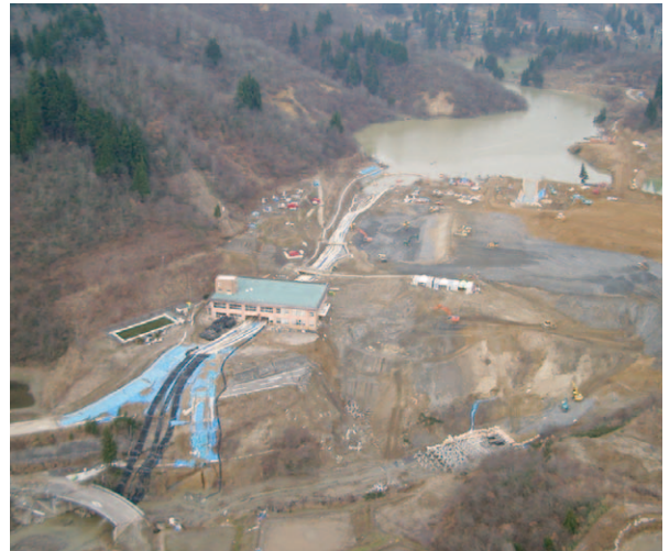
東竹沢の仮排水路施工状況（平成16年12月4日撮影）ポンプを12台に増設し、水位を下げながら表面排水路を施工中
