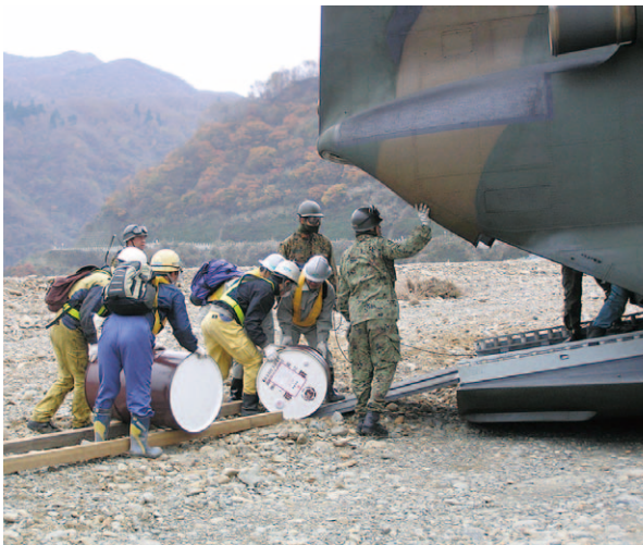
資材の運搬状況（平成16年10月24日撮影）
