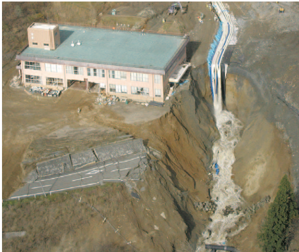
東竹沢の侵食状況（平成16年11月17日撮影）
