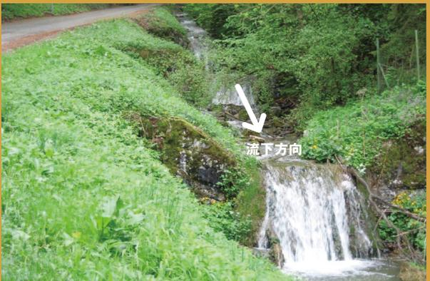
**写真-6** 連続して配置された石積みの床固工(中流部)
