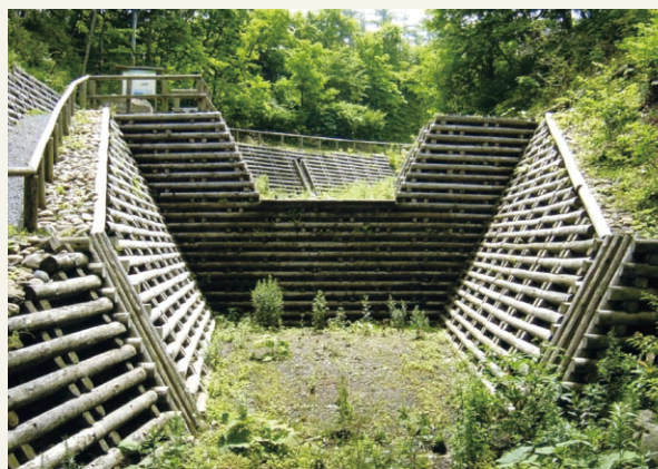
写真-II-3 静穏期の景観保全に配慮した間伐材を利用した床固工・渓流保全工
