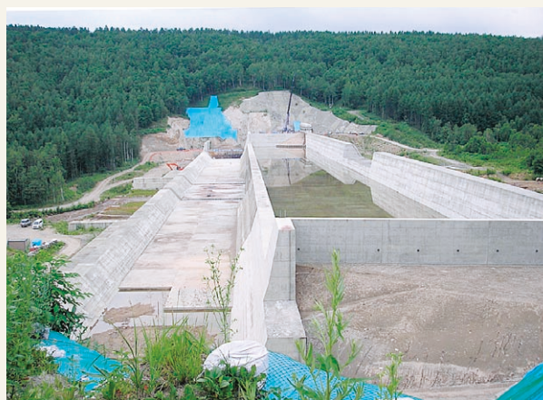
写真-I-2 富良野川3号堰堤の嵩上げ工事状況(平成20年7月撮影)
