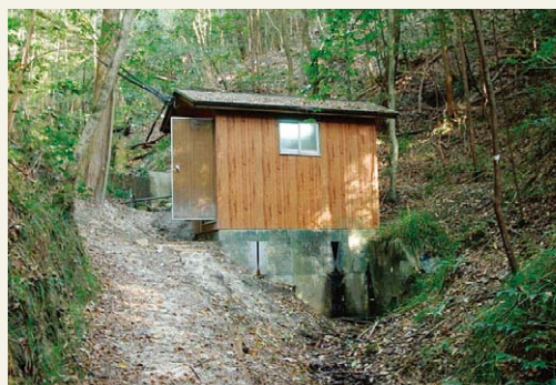
写真-5 北谷上流 地表水・地下水測水所
