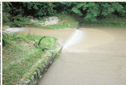
写真-9 白坂量水堰の貯水池における堆砂 2004台風1/4が土壤表層浸食由来の土砂で構成されていると推定された。内部の小流域(0.4ha)で観測される土壤表層浸食量はUSLEを用いてよく再現され、流域全体(88.6ha)へ空間的に拡張を可能にした
