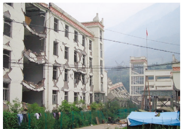
現在の市街地状況(未だ廢墟となっている。地区全体がほとんど全滅のため、再建計画により全く新しい集落に生まれ変わる予定となっている)
