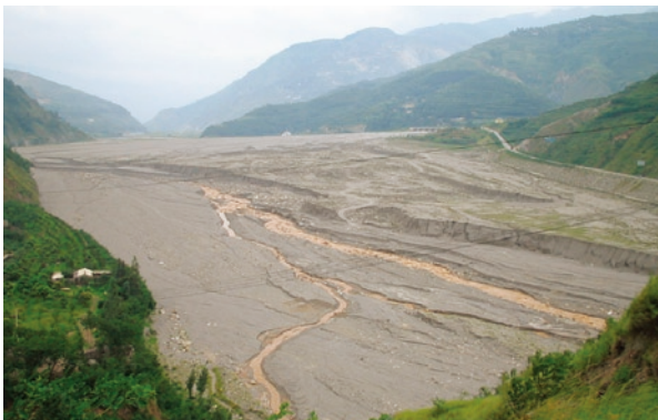
支川からの流出土砂により形成された広大な扇状地
