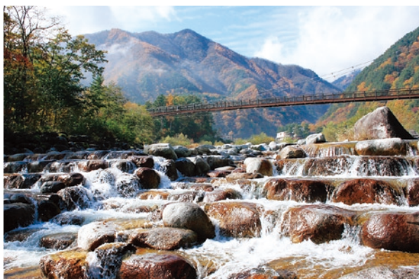
写真-2 太田切床固工群(国土交通省、2009)
