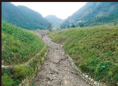
写真-8 北川県魏家溝の土石流発生渓流 2008年9月24日に土石流が発生し20名の人命が失われた。現在は流路が掘削されている
