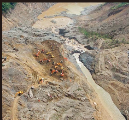
写真-2 重機による緊急排水路の掘削
