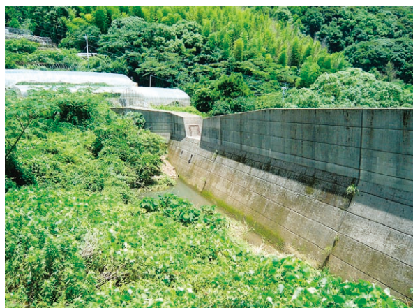
写真-6 地区の上流の砂防ダム
