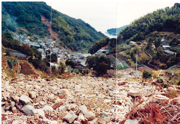
写真-3 長崎豪雨による山川河内地区の災害状況
