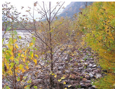
護岸の植生進入状況(平成20年9月)
