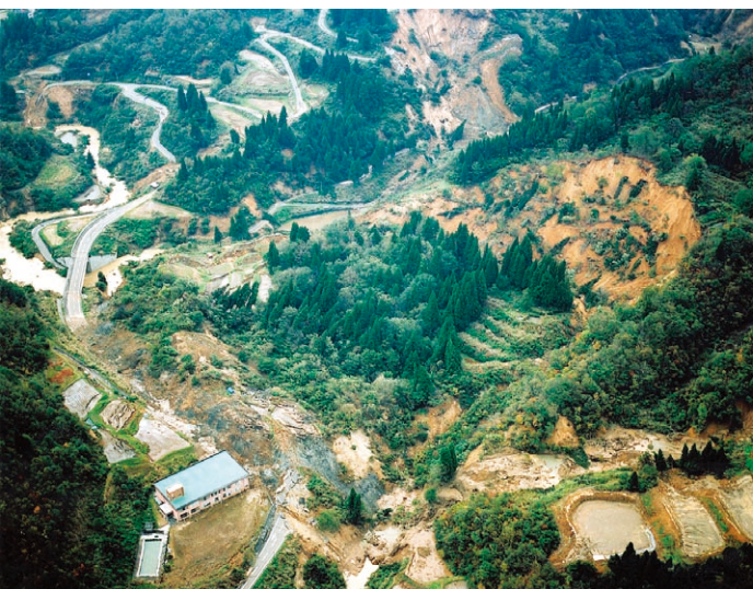
地すべりによる東竹沢地区の河道閉塞・湛水。緊急排水路を確保した平成16年11月18日の状況
