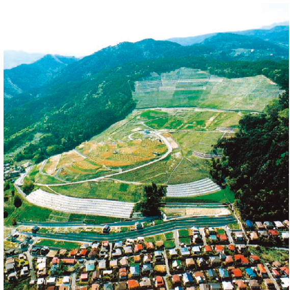
対策工が施工された平成2年6月の状況
