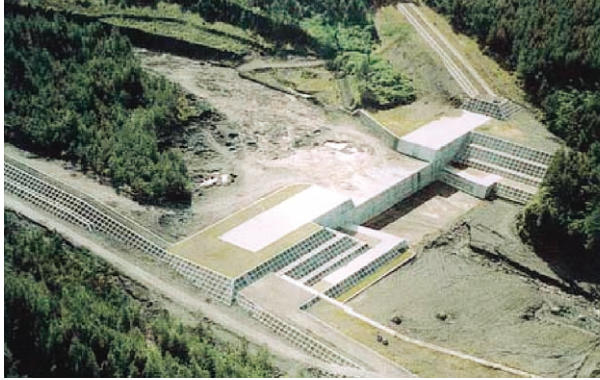
メラピ山麓プティ川ジュランジェロ地区に第二期メラピ砂防事業 (OEFCローン)で完成したダブルウォールえん堤(1993頃の写真)〔「インドネシア砂防技術センタープロジェクト」1994パンフレット〕
