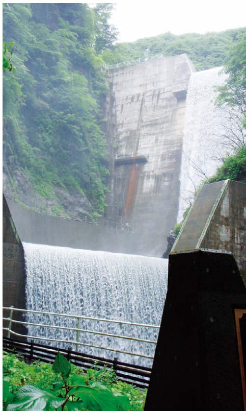
稲又第三砂防えん堤(平成20年6月)
