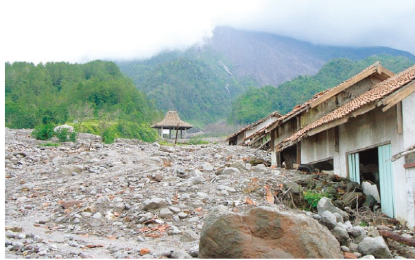
2006年5月に発生した火砕流で被害を受けたゲンドール川上流の集落(2007年3月撮影)
