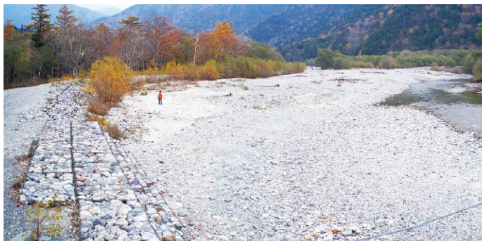
明神橋から見た上流側の状況(平成20年9月)
