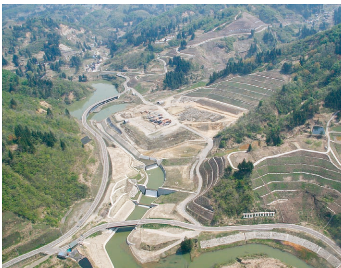
河道閉塞対策が完成した平成18年の状況(湯沢砂防事務所ホームページより)
