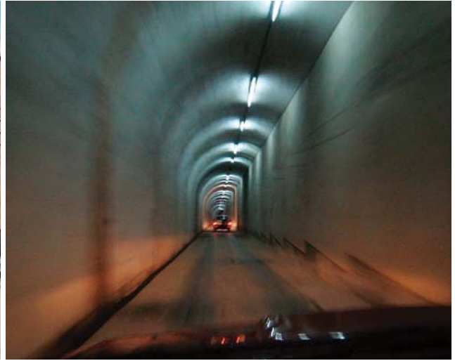
クリカニ第1発電所への地下道、日本からの支援により建設された地下式水力発電施設
