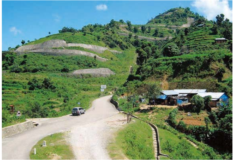
シンズリ道路 (第2工区)
