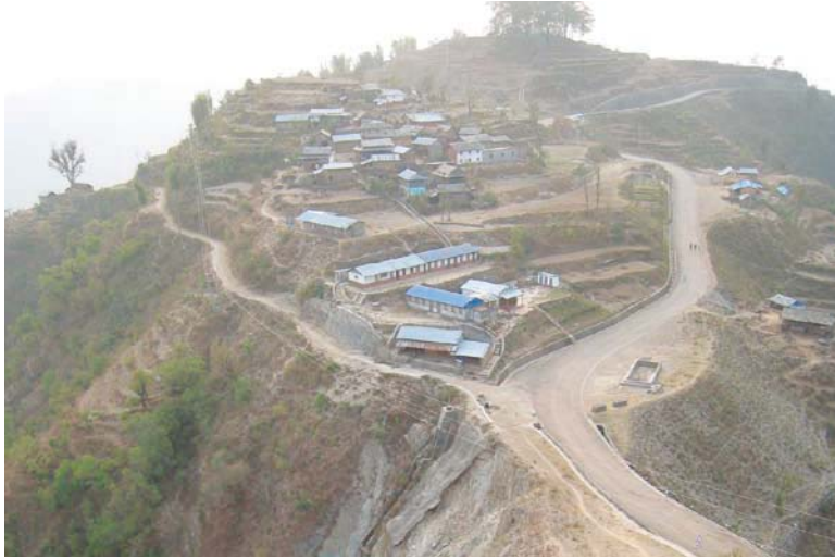
シンズリ道路(第2工区)沿いの崩壊地
