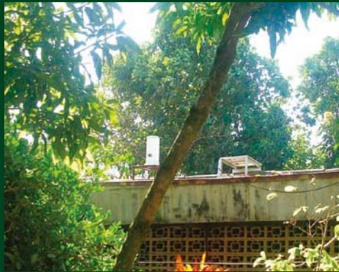
写真-13 エルサルバドル・サンタテクラ市斜面崩壊警報装置(警察署屋上に設置された雨量計)
