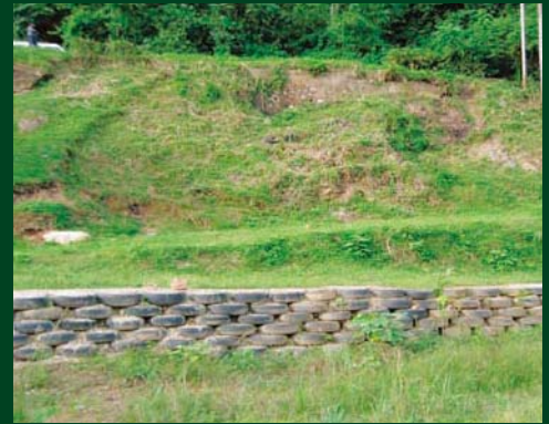
写真-14 古タイヤを利用した護岸(トリニダードトバゴ)
