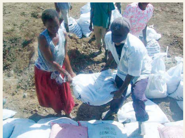
写真-16 コミュニティの人々によるソイルセメント土嚢設置作業(ケニア)
