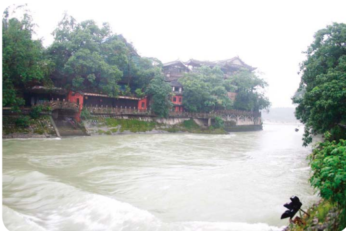
都江堰、宝瓶口：2000年にわたり継承されてきた水路網の取水口 ここより取水された水が四川平野を潤す
