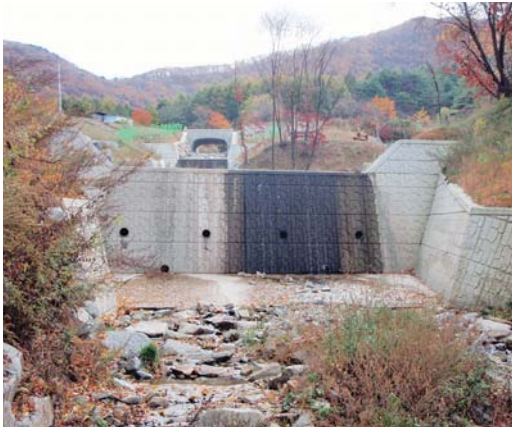
写真-3 3ヶ月で完成したコンクリート製砂防えん堤
