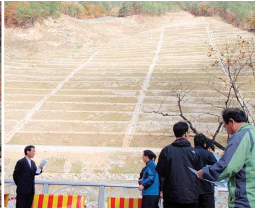
写真-4 長大な溪岸崩壊法面の復旧状況
