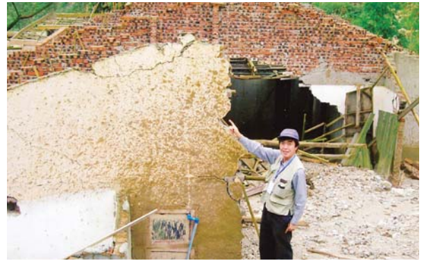
写真-1 土石流で破壊された人家。人物は小長井東大教授
