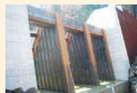
完成状況 / 下流側
