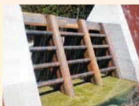
完成状況 / 上流側
