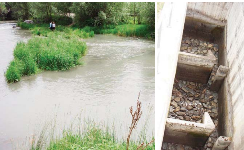
写真-5 アルプスライン川から 分水して造成したピオトーブ
