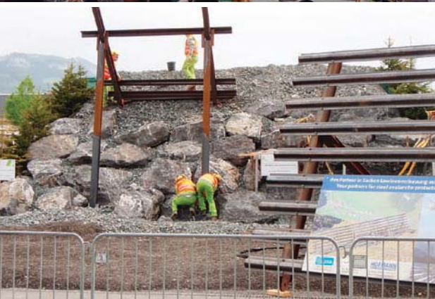
写真-3 応急雪崩対策工のデモンストレーション
