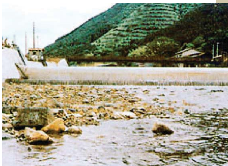
写真-1 関西電力三方川取水ダム
