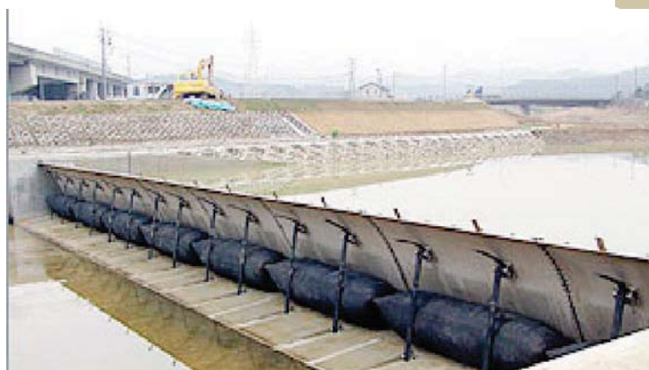
写真-2 電源開発黒谷取水ダム
