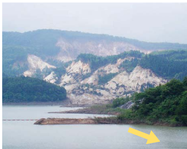
写真-6 荒砥沢地すべりの全景
