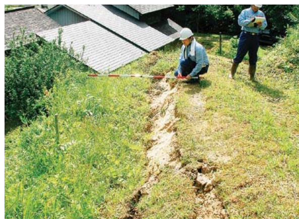
写真-5 危険度A判定箇所の滑落
