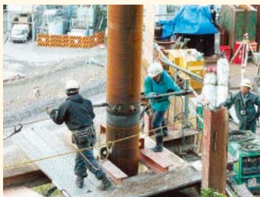
回転接合作業中
