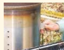
ゲージによる施工完了の確認
