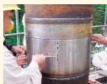
セットボルトのねじ込み
