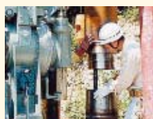
ピン継手の挿入
