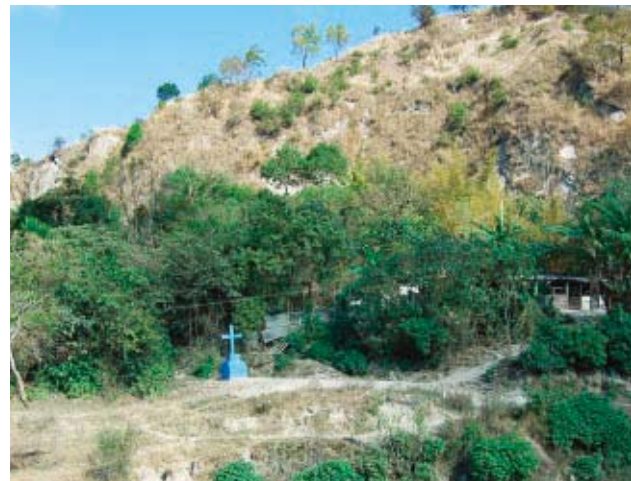
写真-4 Landslide 被災地 (Santa Cruz市)
