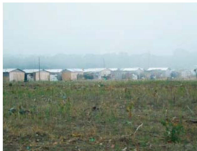
写真-10 被災地の仮設住宅
