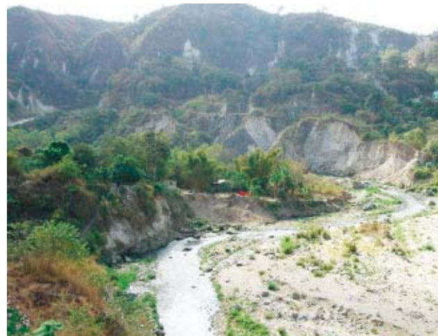
写真-3 山腹崩壊と河岸浸食
