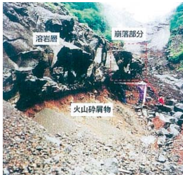
写真-1 現地での谷壁崩壊状況★2
