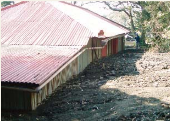
写真-3 土砂に埋没した民家(坪田地区)(平成13年2月、村上治氏撮影)
