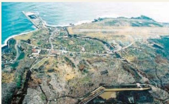
写真-5 平成20年4月26日に再開した三宅空港と全島避難にも使用された三池港を守る砂防えん堤(平成17年2月撮影)
