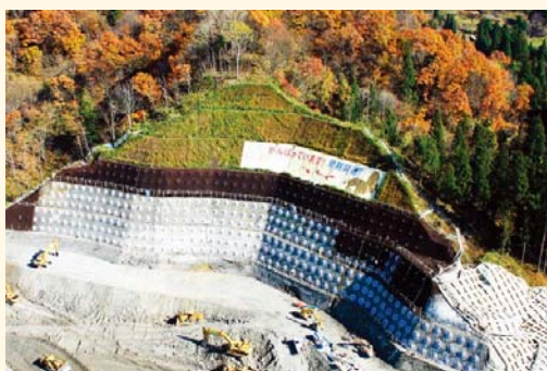
アンカー施工中
