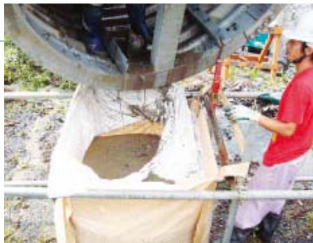
写真-2 流下土砂の採取状況
