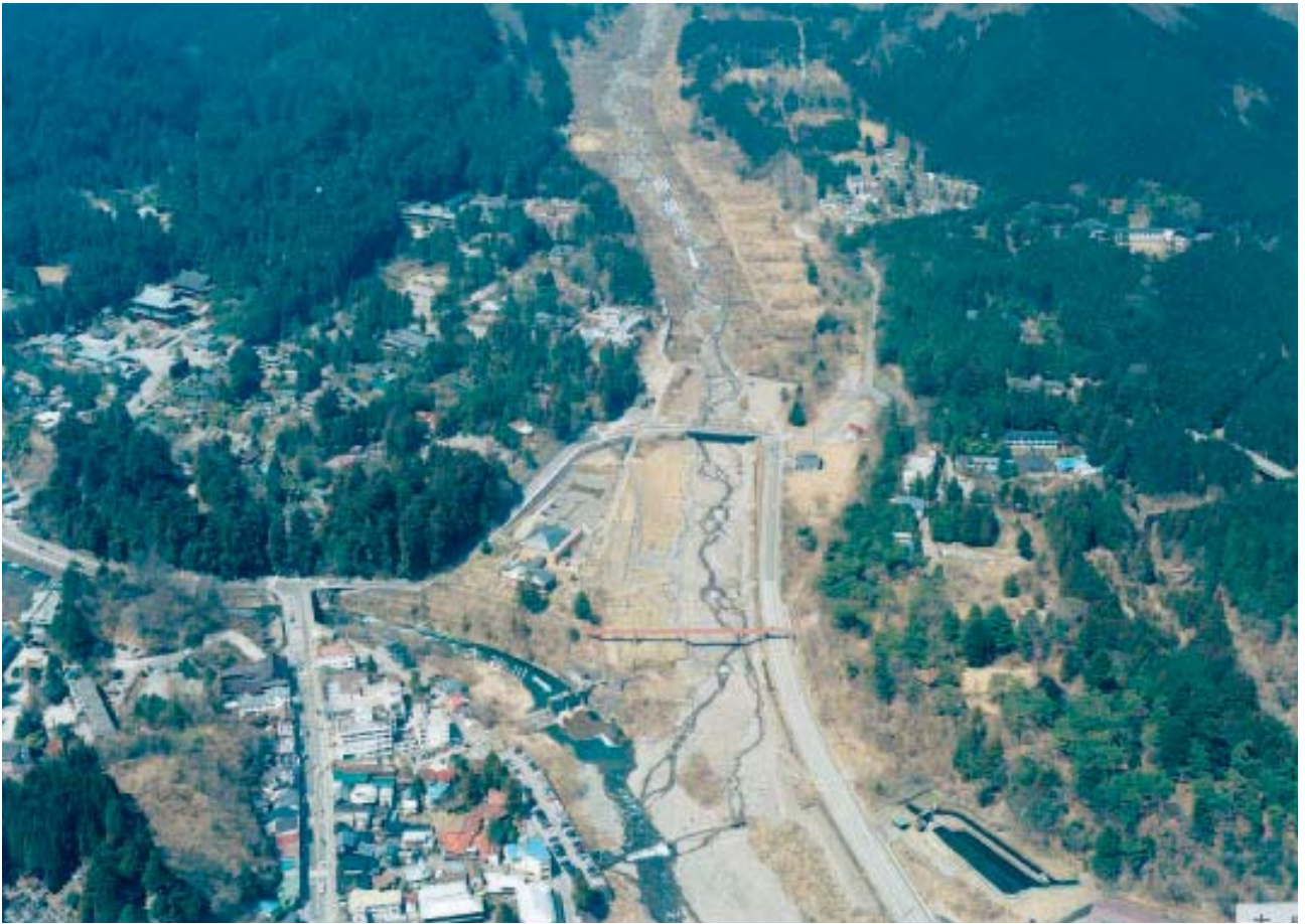
写真-2 現在の稲荷川の状態 (国土交通省日光砂防事務所提供)
