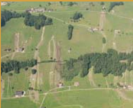
写真-1 土砂災害の例：表層崩壊
