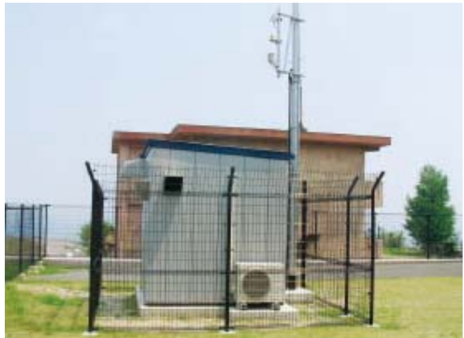
写真-6 自動観測小屋の外観
