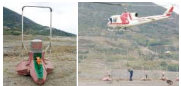
写真-3 新しい反射プリズム 写真-4 ヘリコプターによる反射プリズム設置状況
