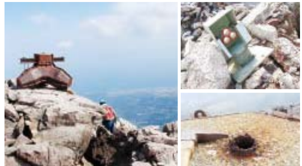
写真-2 プリズム部と躯体の分離状況
