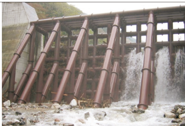
写真-1 格子形2000-c (岐阜県：菅沼谷えん堤)
