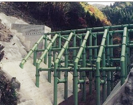
写真-2 格子形鋼製えん堤 (六甲砂防事務所; 松尾第3号砂防ダム)
