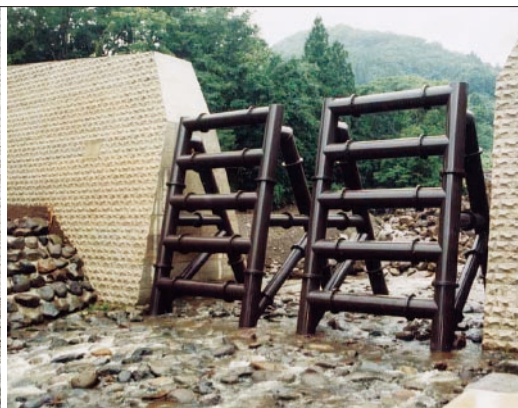
写真-8 L型スリット (長野県; 三郷砂防えん堤)
