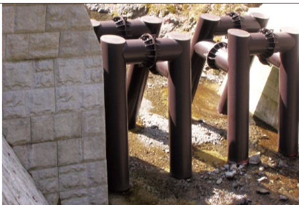
写真-5 B型スリット2003(奈良県宇陀土木事務所；四郷川2号砂防えん堤)
