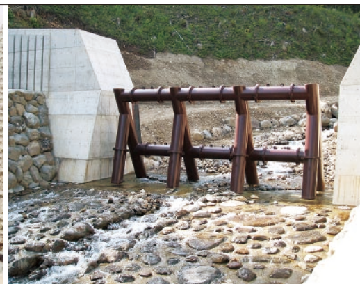
写真-9 J-スリット (湯沢河川国道事務所; 田沢沢川第1号砂防えん堤)
