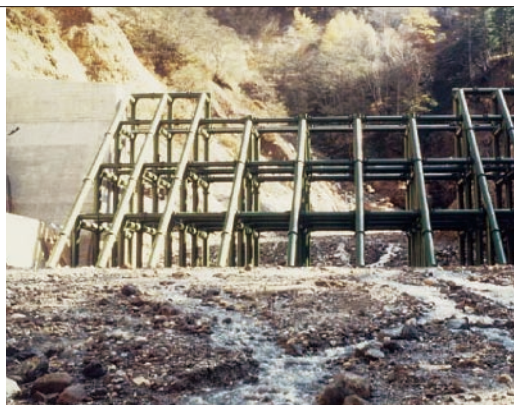
写真-3 格子形鋼製砂防えん堤 (神通川水系砂防事務所; 白水谷2号砂防ダム)
