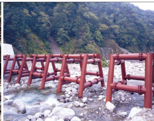
写真-4 B型スリット (多治見砂防国道事務所; 木曾川水系滑川第3砂防えん堤)
