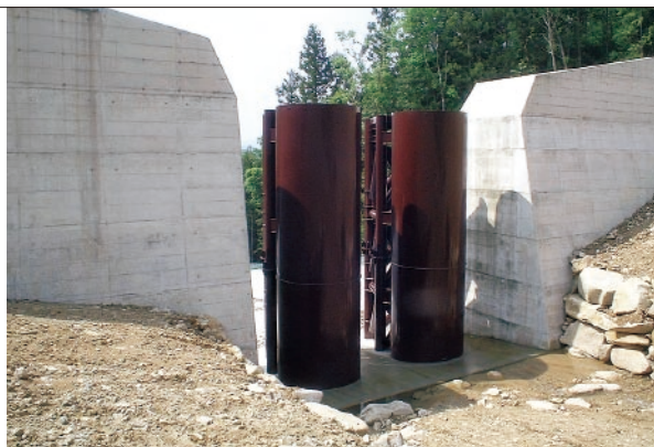
写真-6 CF型スリット(山口県阿東土木事務所；恵比寿谷川砂防えん堤)
