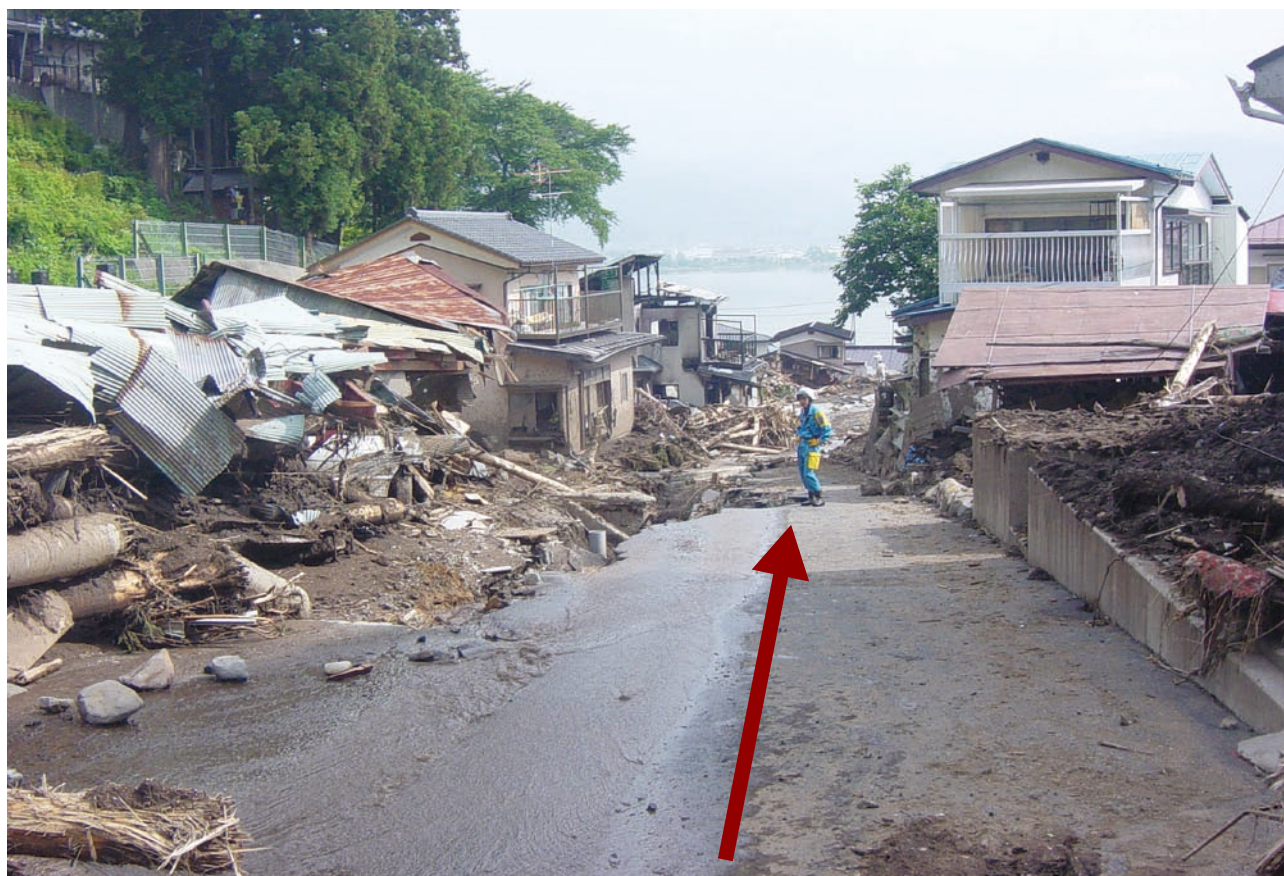
湊地区土石流被災状況(小田井沢下流域)*
