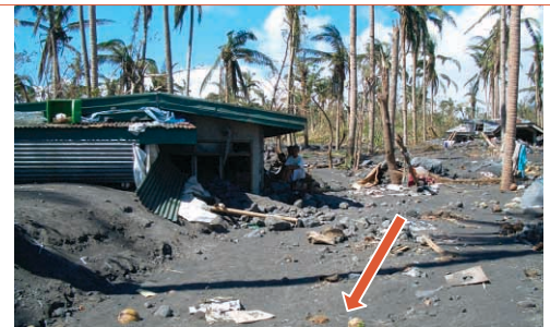
写真-12 泥流で一階の半分程度が埋まった人家
