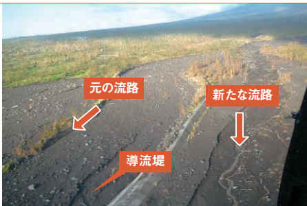
写真-7 導流堤の裏側に新たに形成された流路
